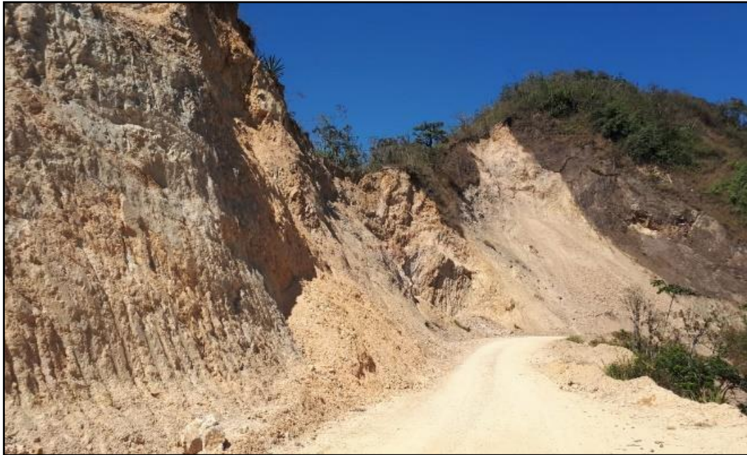
Figura 21 Deslizamiento en el Sitio Guayacán
