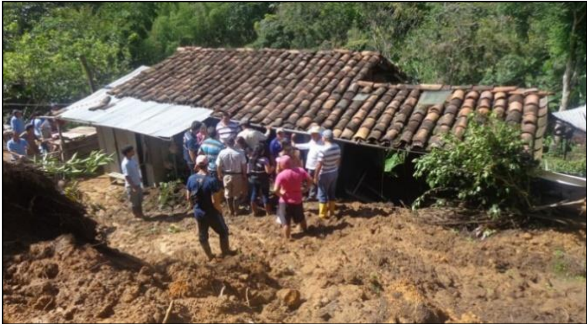
Figura 19 Deslizamiento que afecto a una vivienda
