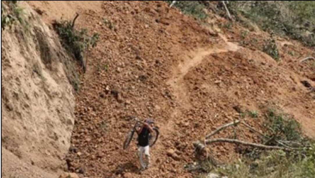
Figura 6 Deslizamiento en la vía Capiro-Guayacán-Los Amarillos
