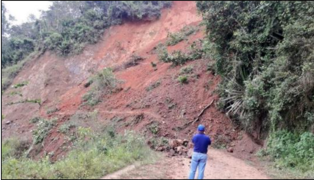
Figura 5 Deslizamiento en la vía Conchicola-Capiro
